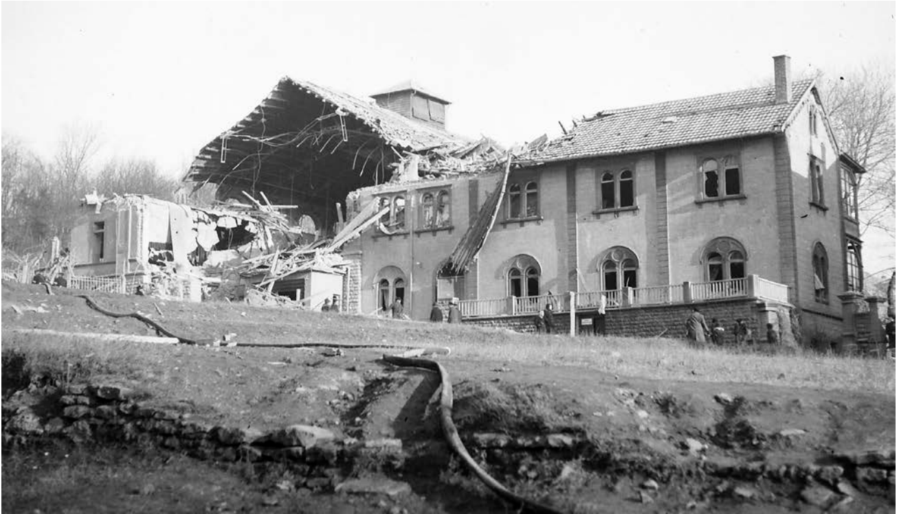
Das beschädigte Turnerheim
